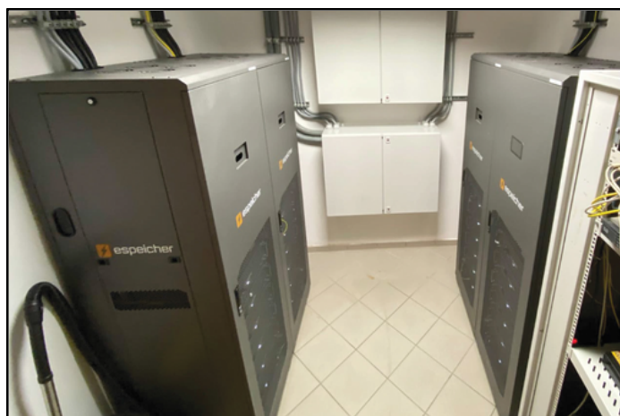
Kühlwarenlogistik: 60kVA-120kWh
